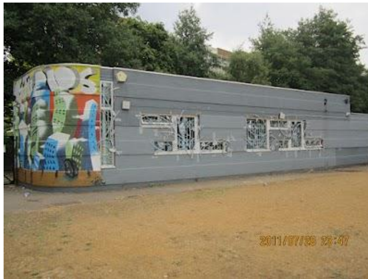
【センターの外観】
